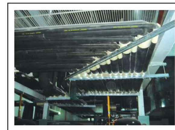
工程管路 Piping
